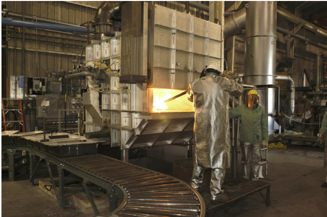
图 2: 2000 磅熔炉安装完成
